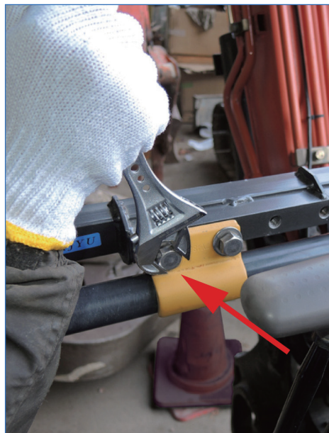
【1】H型フレームを、同梱のクリップを用いて、17mmスパナ等で手すりによりしっかり固定します。
