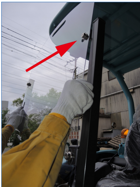
【2】PCパネルをボルト部にはめ込みます（ハンガー式）。
