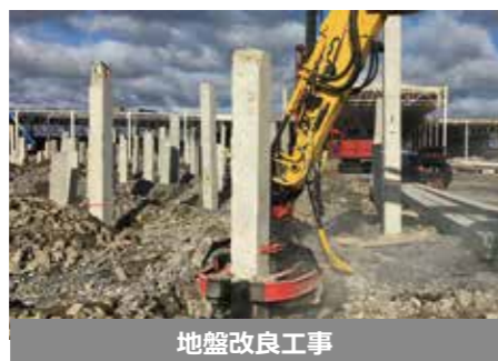
河・川・湖などの建築パイル撤去工事
